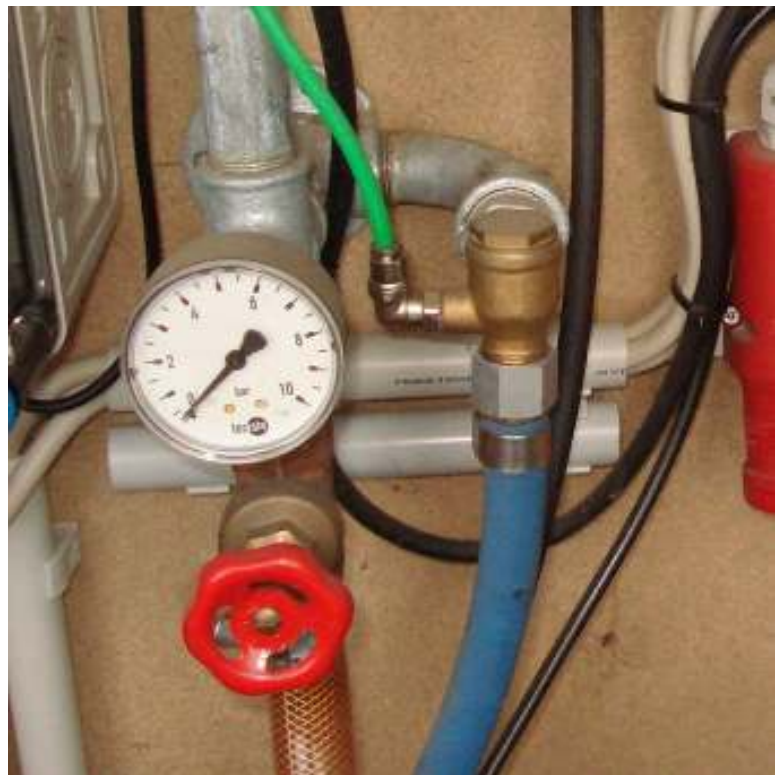
Manometer, Absperrinrichtung, Steuerleitung; Bild 20
