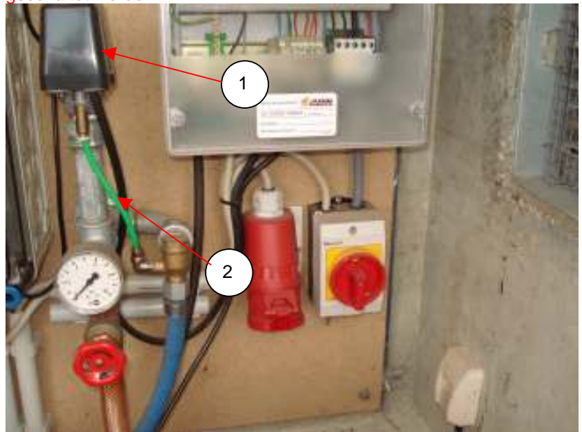
Stationschrank rechte Seite, Druckarmaturen; Bild 19
