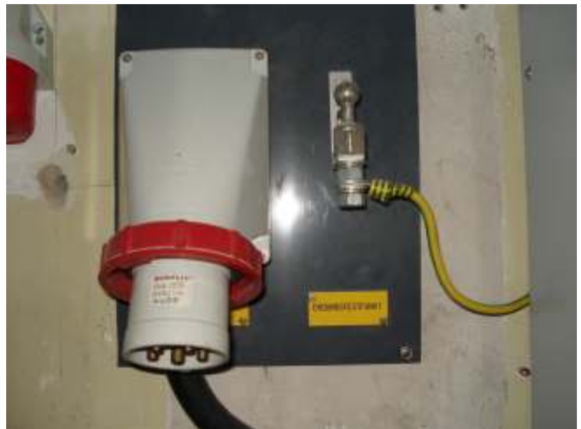
Notstromeinspeisung; Bild 06
