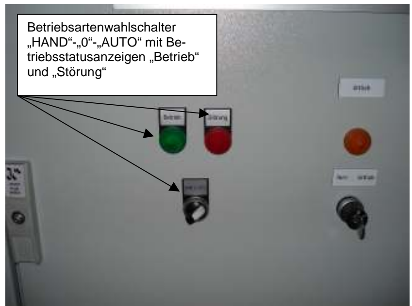
Bedienfeld links, Pumpe 1; Bild 22
