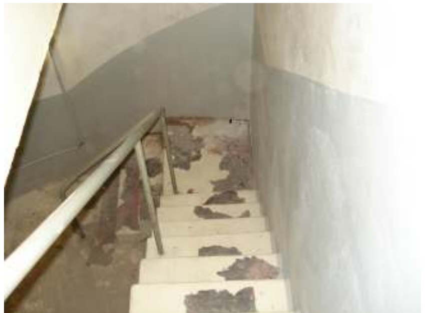
Abgang Pumpenkeller; Bild 31
