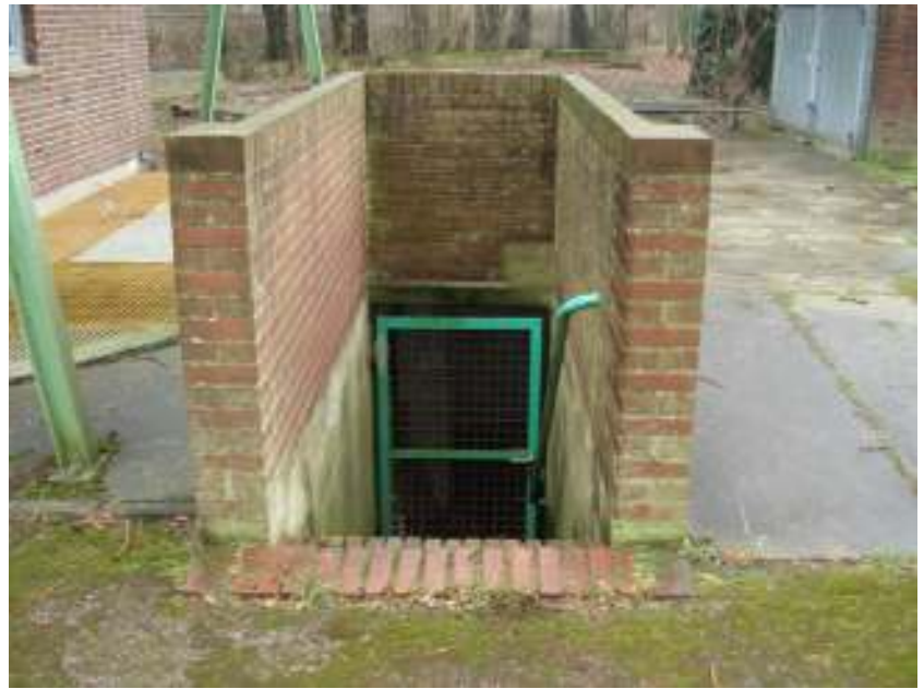
Zugang Zulaufgrinnen; Bild 13
