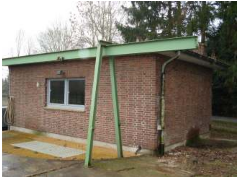
Kranbahn vor dem Hochbau; Bild 28
