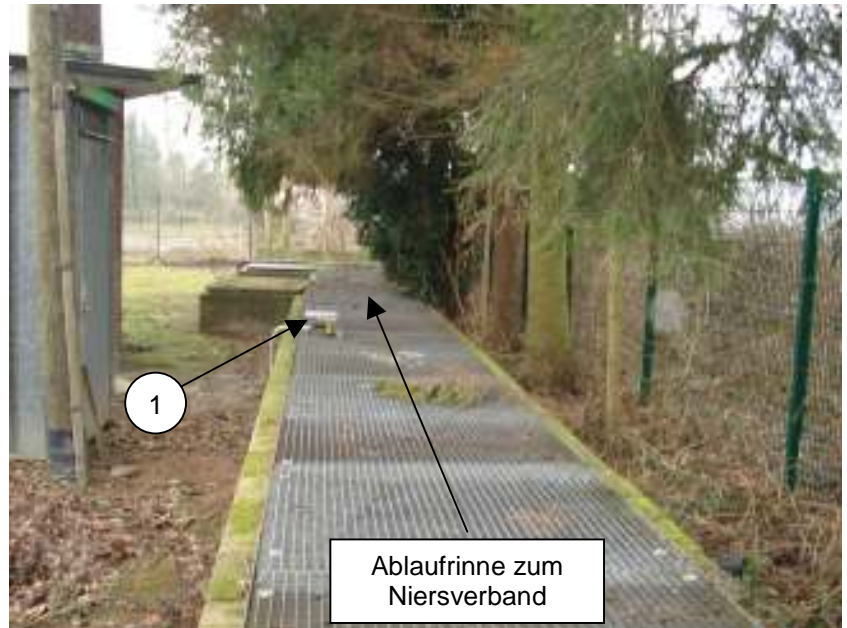
Ablaufrinne zum Ablaufsammler DN 500; Bild 19
